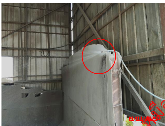
ระบบระบายน้ำบริเวณแหล่งกำเนิดฝุ่นละออง
